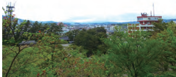
由利本荘市中心部の旧本荘地域。同市の人口約7万人の半分が住む地域だが、内水氾濫による床下浸水や床上浸水が頻発している。同市は実証実験で、この地域に水位計や監視カメラを設置した
